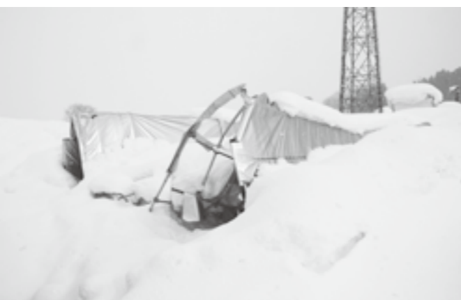
↑一晩の積雪量が多かったため除雪が間に合わず倒壊したパイプ倉庫
