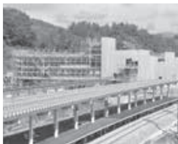
建設の進む立体駐車場(10月24日撮影)
