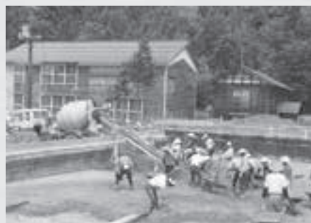
プール建設工事
